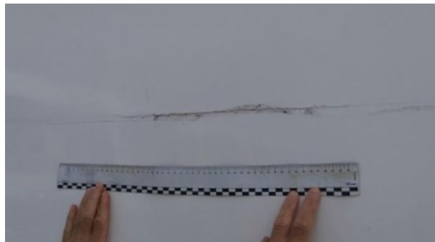
Zijpanelen: Kras met verwijderd materiaal \geq 20 cm nog economisch verantwoord te repareren. Optie om half paneel te spuiten
