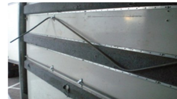
Bekleding en stangen: Stangen, bevestigingen, bekleding ontbreken of vervormd, reparatie niet meer economisch verantwoord
