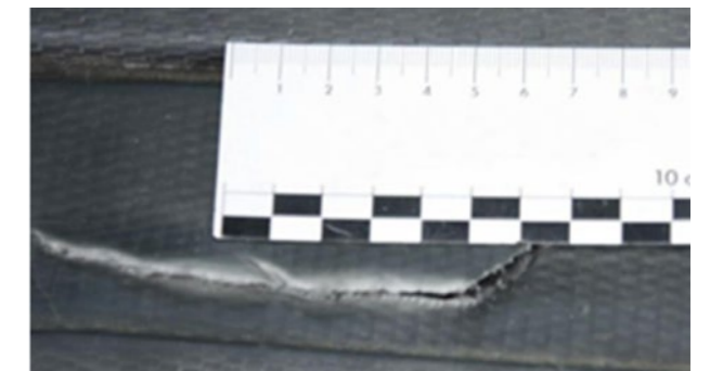
Perforatie van hard kunststof bekleding. Reparatie van hard kunststof bekleding | standaard uurtarief indien esthetisch acceptabel en reparabel
