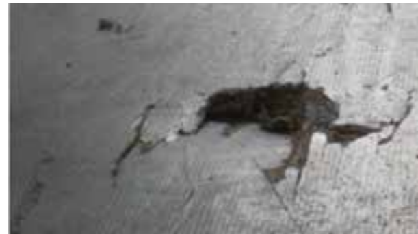
Vloerbedekking: Economisch verantwoord te repareren vervormingen of perforaties
