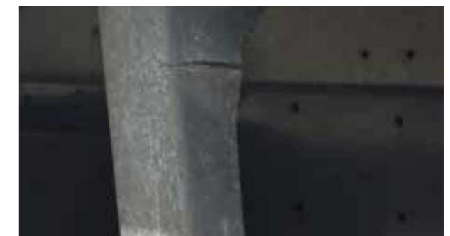
Fietsenrekken: Vervorming niet economisch verantwoord te repareren
