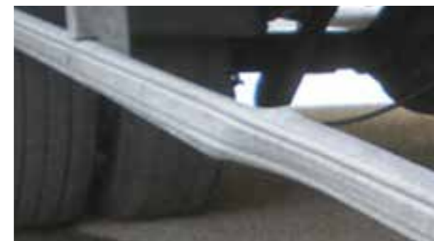
Fietsenrekken: Vervorming niet economisch verantwoord te repareren
